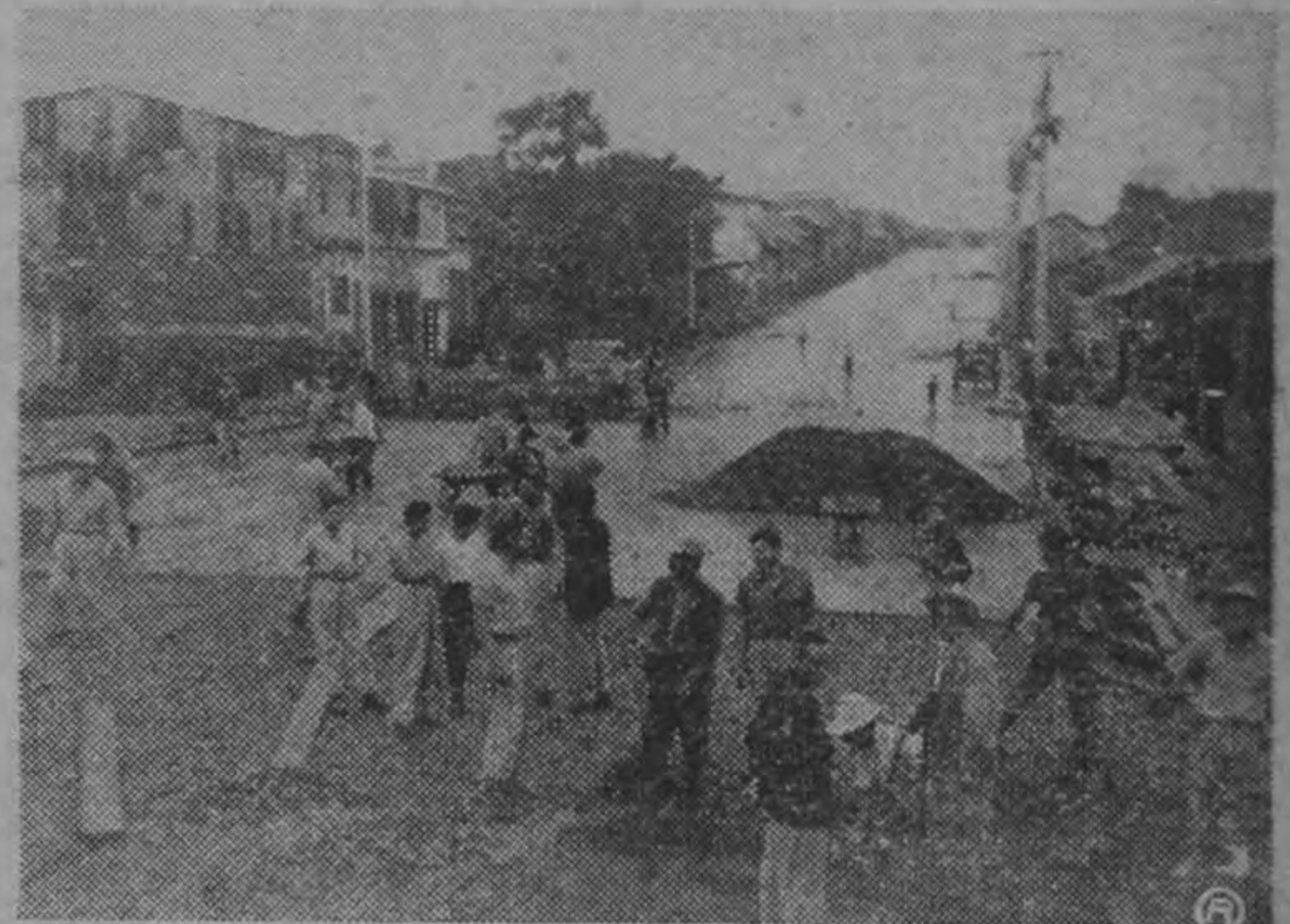
LA AVENIDA MAS AMPLIA DEL PAIS.—Trabaja todo día y noche, las cuadrillas de la Municipalidad de San José dejarán terminada hoy la pavimentación de la Avenida de los Cementerios, que será a más anchura del país, ya que tiene de asera a asera, 17 metros. Será inaugurada el domingo 2 de Noviembre.
